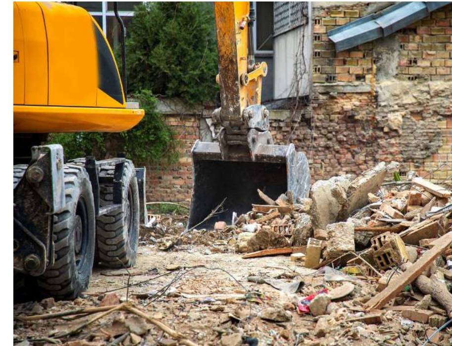
Limpieza de terrenos
